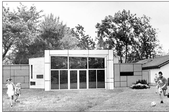
Wird mit Zuschüssen von Bund und ARD-Fernsehlottarie errichtet: der Erweiterungsbau, der sich direkt an eines der Kinderhäuser (rechts) anschließt. Das Freigelände wird danach umgestaltet.
